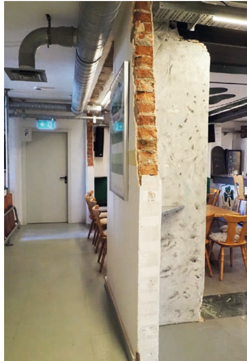
Ganz abgebrochen wurden die Mauern nicht. Es blieben Reste bestehen
