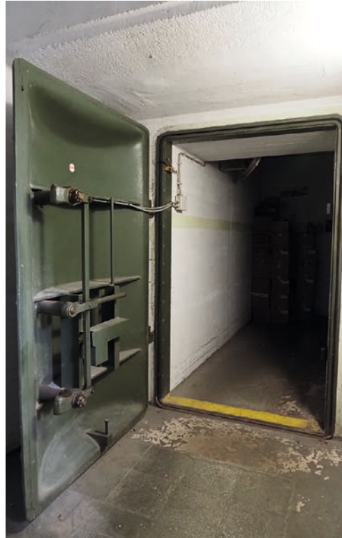
Beklemmend: der Eingang in den Bunker. Hinter der geschlossenen Türe wäre im Ernstfall noch eine Wand aus Metallblöcken aufgeschichtet worden
